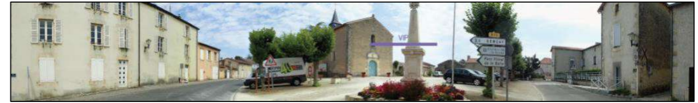
Figure 289 : Depuis la place de l'église, le VIP est en grande partie tronqué par les constructions ; il est peu prégnant (Source : Étude paysagère de l'Agence COÛASNON)
