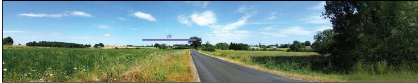
Figure 248 : Depuis la frange est de La Ferrière-Airoux, le VIP est visible en concurrence avec le clocher (Source : Étude paysagère de l'Agence COÜASNON)
