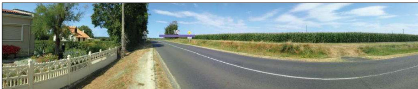
Figure 237 : Sortie de bourg vers la ZIP à Sommière-du-Clain, le VIP est tronqué par la végétation (Source : Étude paysagère de l'Agence COÛASNON)
