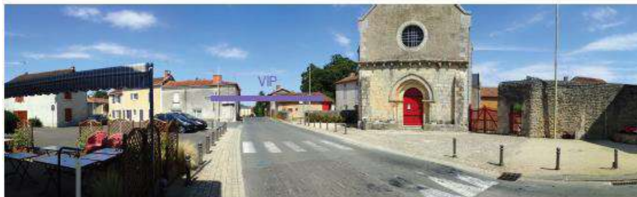
Figure 258 : Depuis les abords de l'église, au bord de la RD 1, le VIP est visible dans l'axe de la route mais en grande partie tronqué par la trame bâtie
