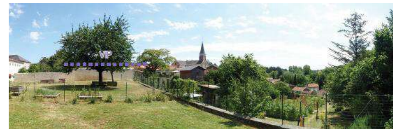
Figure 308 : Vue depuis les jardins du château, le VIP est masqué par le relief, la végétation et les constructions du centre-bourg (Source : Étude paysagère de l'Agence COÛASNON)
